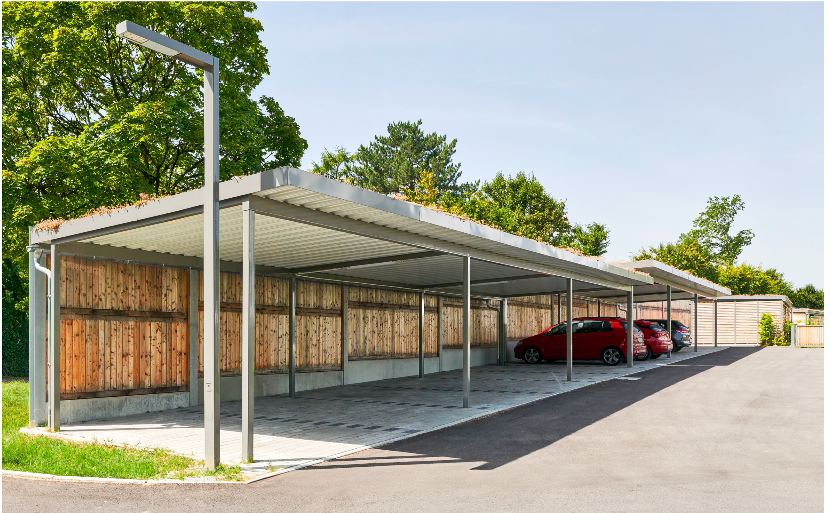
Carport met groendak, achterwand door de opdrachtgever verzorgd.
